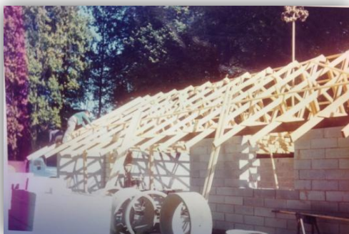
Klubhuset, mens der var rigtig gang i byggeriet. Her kort tid efter 1. spadestik og rejsegildet. Billedet er fra sommeren 1972
